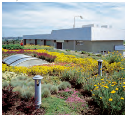
Krovne bašte Strana 30-35
