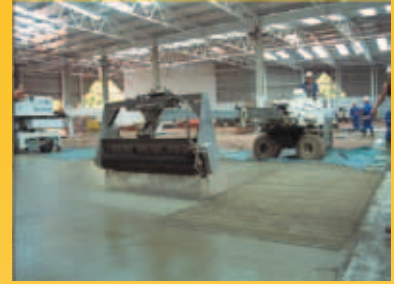
Nanošenje suvog posipa
