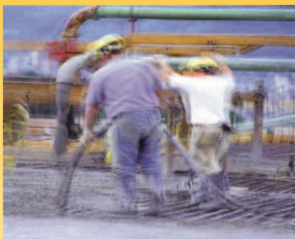
Ugradnja bez vibriranja
