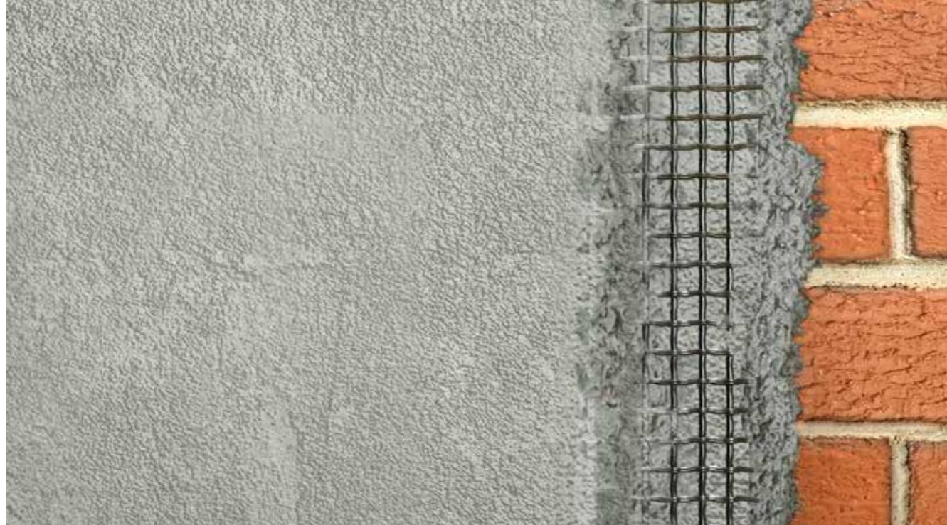
Patentirana mreža od karbonskih vlakana koja se ugrađuje u posebno dizajnirani reparturni malter za ojačanje betonskih ili zidanih konstrukcija.
