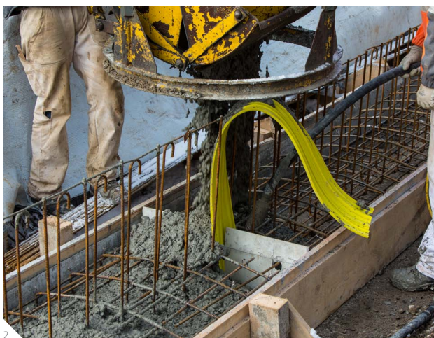
2 Sika „bela kada“ / Vodonepropusni beton
