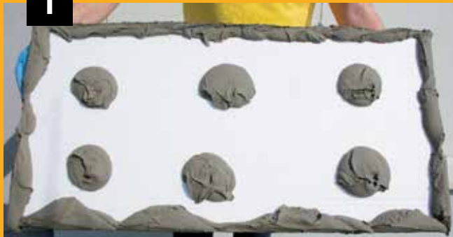
Lepljenje EPS izolacione ploče Fixing of EPS insulation boards
