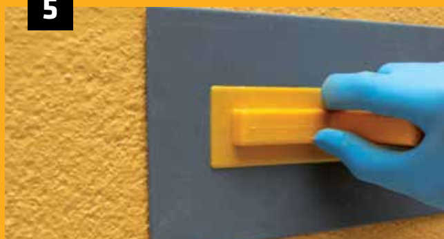
Ugradnja završnog dekorativnog maltera Application of decorative finishing renders
