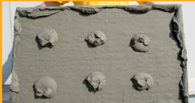
Lepljenje MW izolacione ploče Fixing of MW insulation boards
