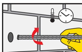
9. Kružnim pokretom ubacite anker u lepkom napunjenu rupu. Anker se mora postaviti u toku otvorenog vremena. Određena količina lepka mora izaći iz rupe.
