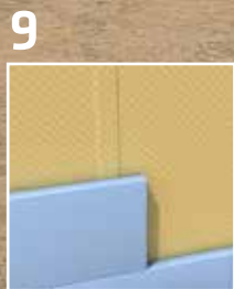
9 WT protection sheet/ filc i termoizolacione ploče
