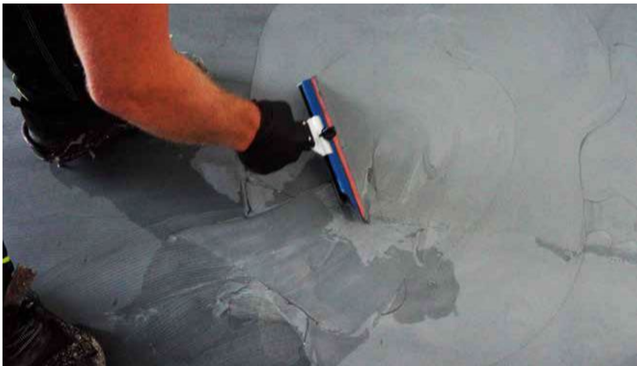
Sikafloor®-3000 FX razmazuje se po površini i zatim obrađuje različitim alatima. U zavisnosti od upotrebljenog alata pod dobija svoj jedinstveni izgled.
