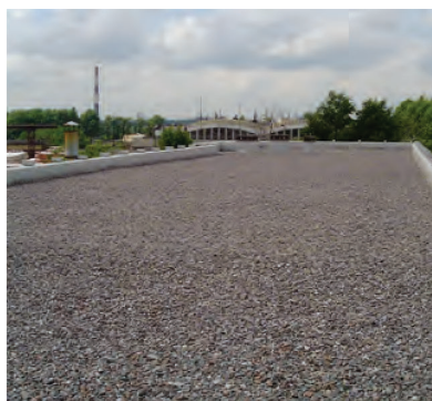
Krovovi sa balastom od šljunka Strana 24-29
