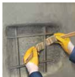
Nanošenje Sika Mono Top 910 na beton kao veza stari-novi beton
